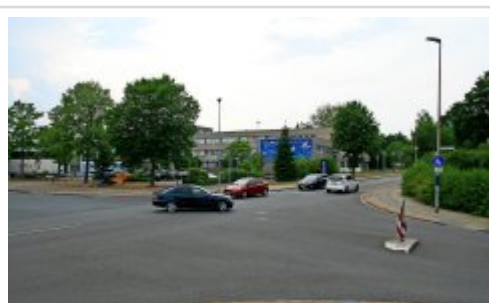
Der Kreuzungsbereich der Gutenbergstraße zur Mergenthalerstraße (links im Bild) und der Otto-Hahn-Straße (rechts) wird einen kleinen, bei Bedarf auch in der Mitte überfahrbaren Kreisels erhalten. Fotos: Astrid Köhler (3)
